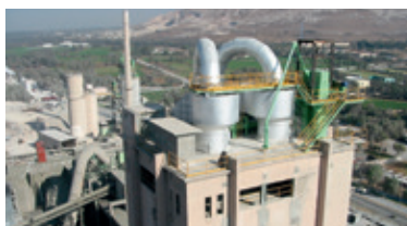
HOLCIM APASCO, Mexiko Zementwerk
