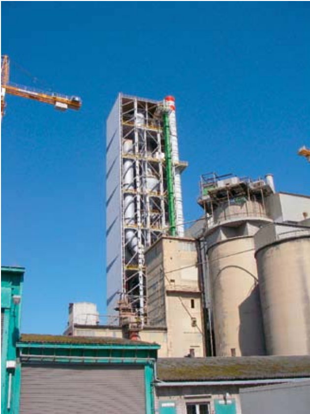
4 A TEC Suspensions-Wärmetauscher bei Lafarge Zement A TEC suspension heat exchanger at Lafarge Cement
